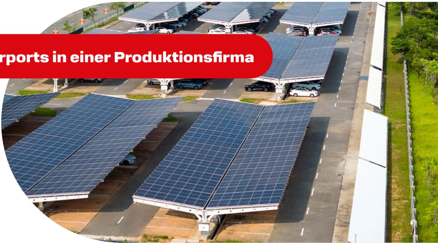
Eine der Flaggschiff-Installationen, deren Bauherr ein auf die Produktion von Lagern spezialisiertes Unternehmen war, ist ein Parkplatz mit einer Fläche von 5.050 m<sup>2</sup>, das mit Carports mit einer Gesamtleistung von 854 kWp belegt ist. Die Installation von Carports in einem Produktionsunternehmen ist ein of-
